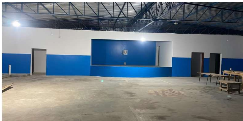
Figura- Vista interna do palco, ainda em reforma.
