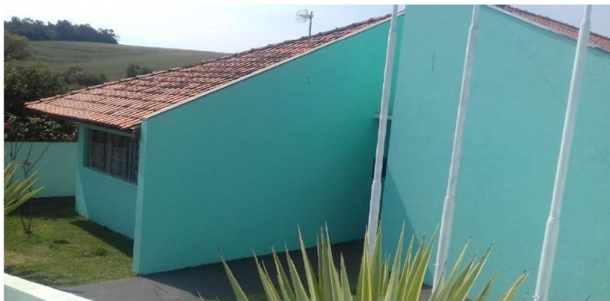
Figura. fachada da Biblioteca Ana Joaquina
